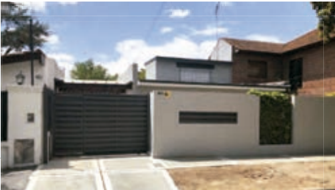
SAN ISIDRO: Casa en PB. refac. a nuevo. 3 dorm. 1 suite, liv. com. con hogar, coc. com. lav. integ, dep. escrit. 3 baños, jardín, pil, parr. Gge 2 autos, lugar para bicis. U$S 360.000.-
