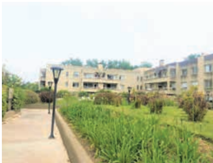
SUCRE SAN ISIDRO. Complejo Sucre, jardines, pileta, seguridad. CONSULTAR.-
