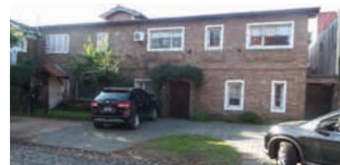
LOMAS SAN ISIDRO: S/calle adoquinada. Aberturas de PVC con doble vidrio. Hall . Toil. Liv.com.con pisos tarugados. Escrit. coc.com.diario. Dep. Lavadero. PA: 4 dor, ppal en suite + otro baño comp. Play. Calefacción por estufas.Muy linda galería con parrilla, tipo quincho. Muy lindo jardín con pileta. VIG. US$ 480.000.-
