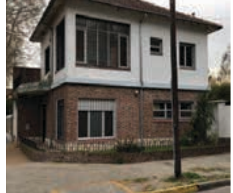
MARTINEZ: Casa PA 3 dormitorios, baño, terraza. PB: living comedor, cocina comedor, dependencia de servicio, toilette, Baño , jardín, Garage. 2 autos. VENTA U$S 349.000.-
